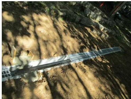
蓮岡お稲荷さん前U字溝設置
