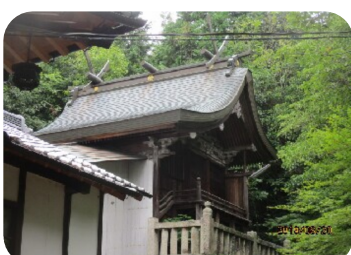
北東方向からみた本殿
