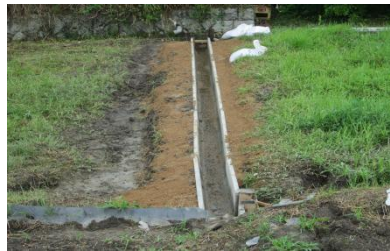
U字溝新設
