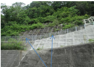
県道62号線フェンス設置
