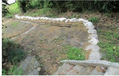
崩落現場上部に土嚢布設
