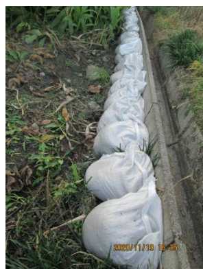
U字溝補強
