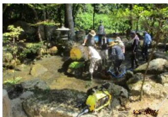
噴水池の清掃作業中
